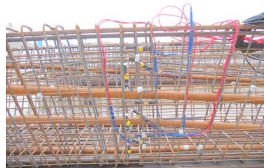
(d) Strain gage impeded in the girder
